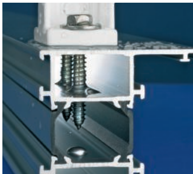
Feuchtigkeitseintritt in Aluminiumprofil
