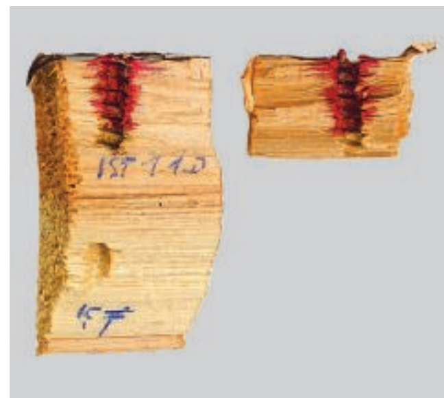
Feuchtigkeitsschaden im Schraubkanal
